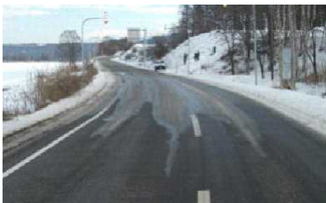
樹林による日陰部分の一部凍結
