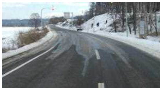
一部凍結した道路
