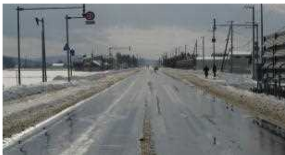
湿潤、凍結した道路
