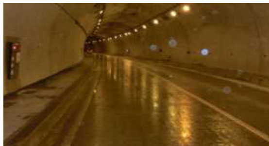
一部凍結したトンネル
