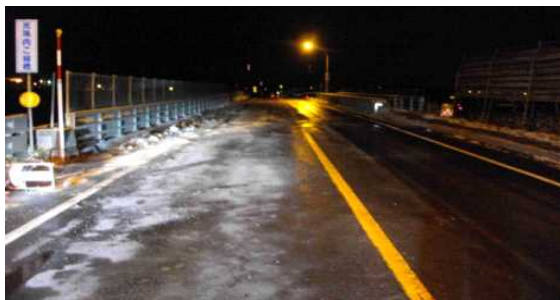
一部凍結した橋の上
