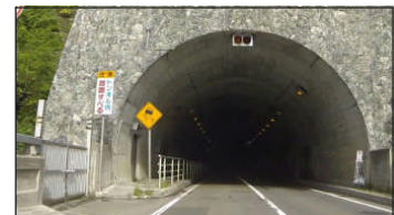
写真2 トンネル入口(暗順応イメージ)
