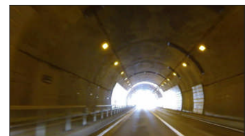
写真3 トンネル出口(明順応イメージ)
