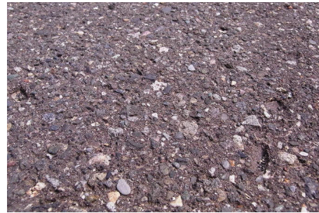
写真20 アスファルト路面(接写)
