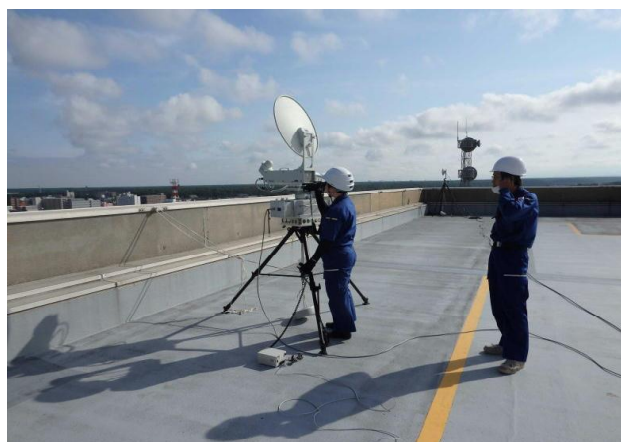
【デジタルヘリコプターテレビ用可搬形 自動追尾受信設備設置状況】
