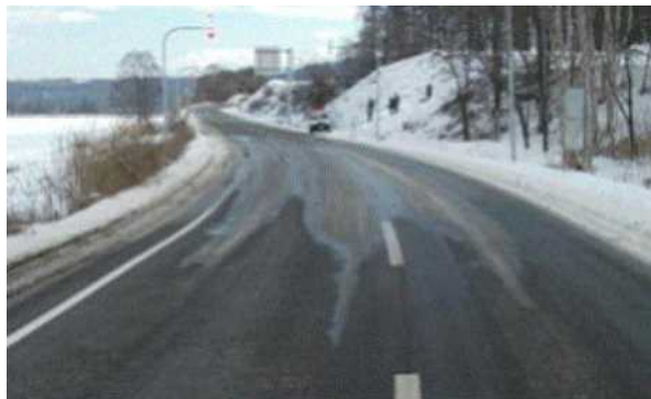
樹林による一部凍結路面
