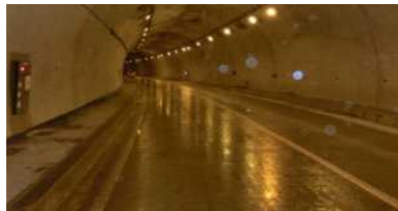
一部凍結したトンネル
