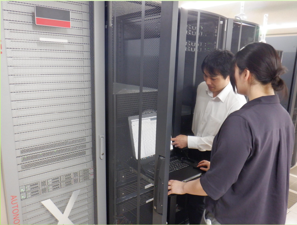
サーバメンテナンス作業
