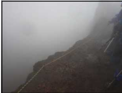
登山道の崩落(鷺泊9合目)
