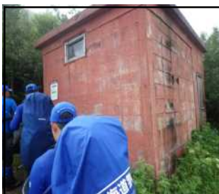
避難小屋の状況(杓形7合目)
