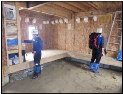
避難小屋内部の状況
