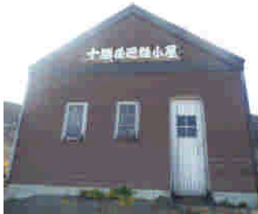
十勝岳避難小屋の状況
