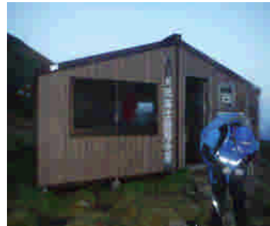
美瑛富士避難小屋の状況
