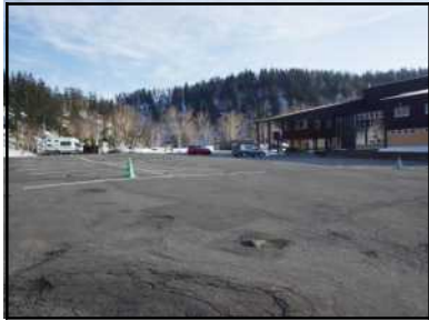
駐車場の状況
