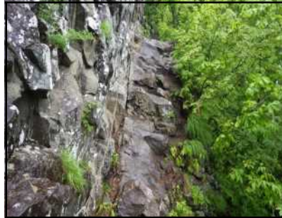
八剣山の危険箇所(ロープ設置)
